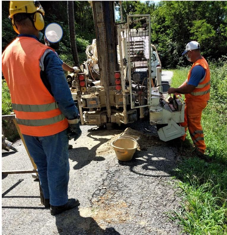
Foto 9 - Posizionamento dell'attrezzatura e realizzazione del foro sondaggio
