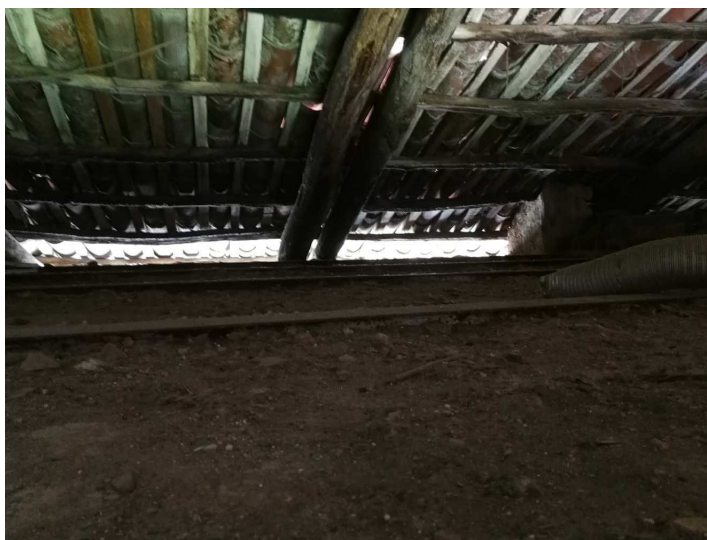
Manto di copertura visto dall'interno dell'edificio ex Scuola Elementare
