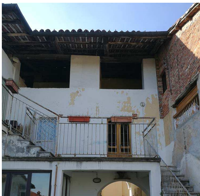
Manto di copertura visto dal cortile interno dell'edificio ex Scuola Elementare
