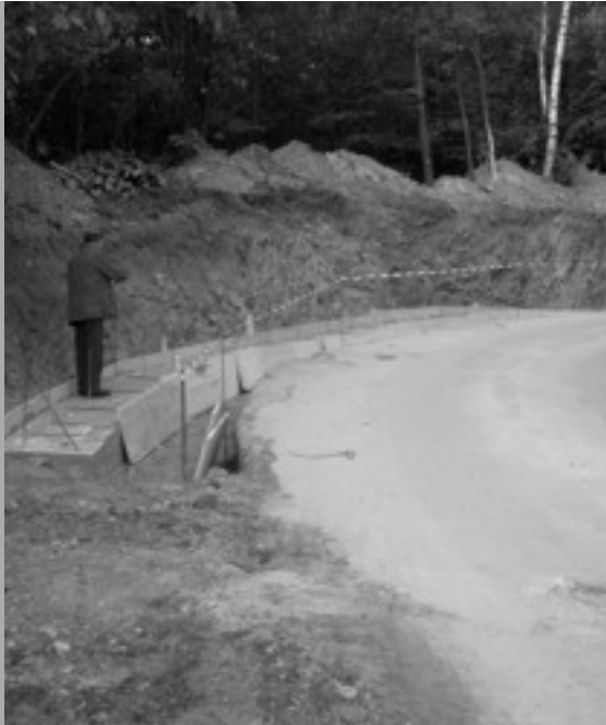
Fondazione allargamento curva via Feipiano
