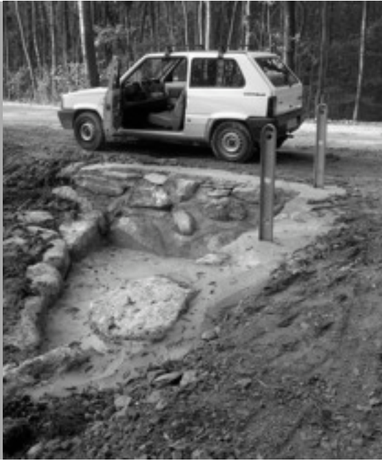
Opere di regimentazione acque in Via Vespa
